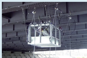
足場本体リフトダウン
