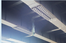
障害物例（鉄鋼継手部、横断方向排水管）
