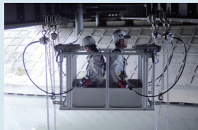
パワーホイスト、吊りチェーン設置
